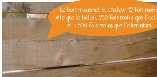
Bardage résineux (plateforme de la Mouille - Jura)
